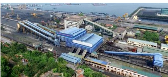
Các Tổ Hợp Nhà máy Than Cửa Ông
