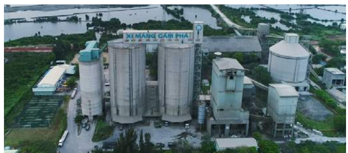
Nhà Máy Xi Măng Cẩm Phả
